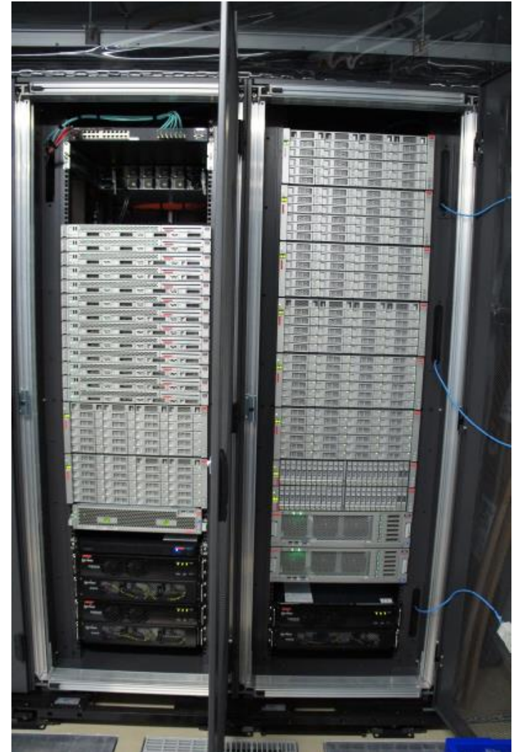
ファイルサーバ(一部)
